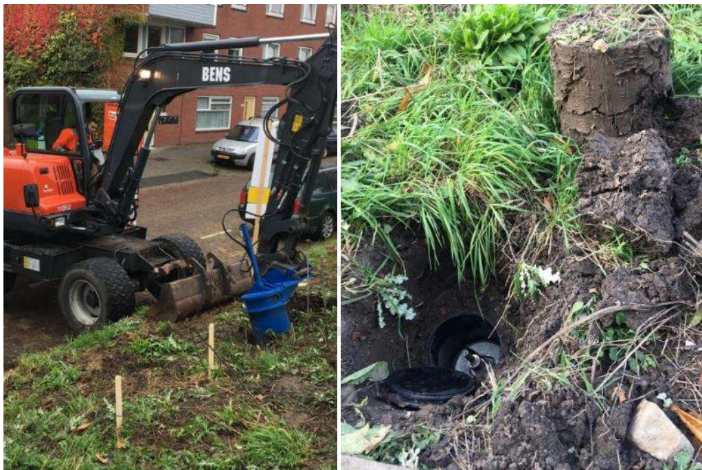
Figuur 5-4 Met de grondbus wordt de plag boven de pot uitgestoken (links), de pot is bereikbaar en de plag blijft bij vochtige grond intact (rechts).
