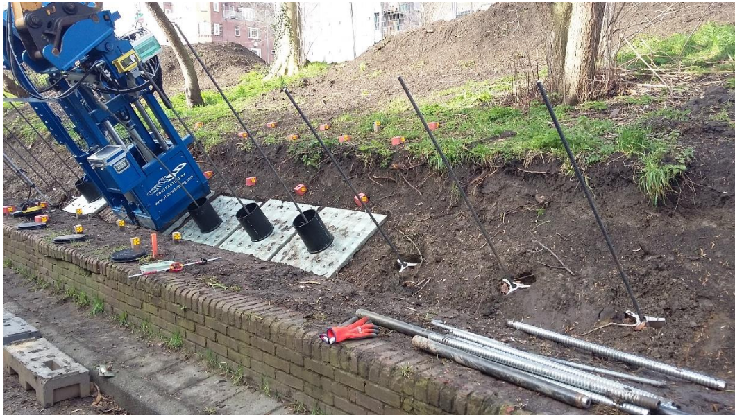
Foto 4-3: aanspannen kopplaten, Ringdijk Watergraafsmeer
