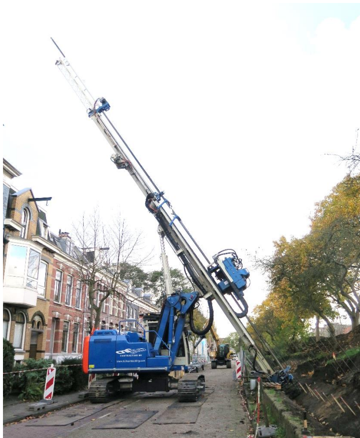
Foto 4-1: JLD-ankermachine, inbrengen JLD-anker, Ringdijk Watergraafsmeer
