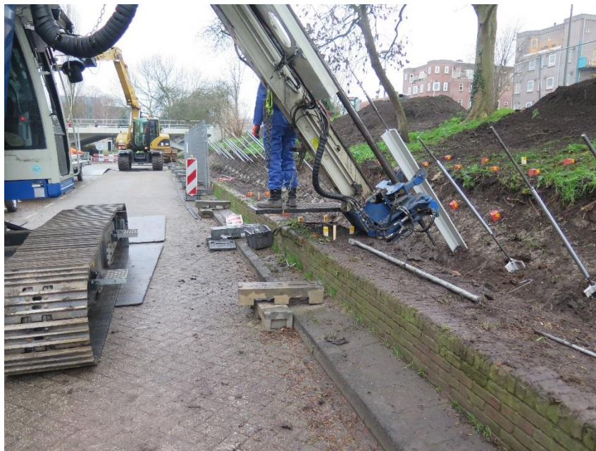
Foto 4-2: JLD-ankermachine, inbrengen LDE-element, Ringdijk Watergraafsmeer
