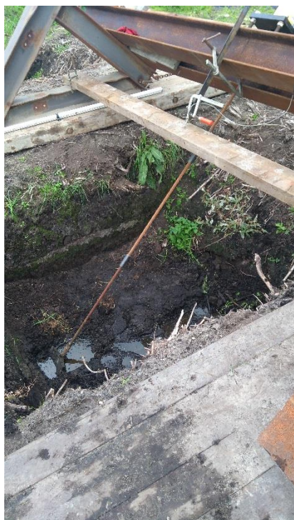
Figuur 6-7: Foto van proef 3, hieruit blijkt dat ten tijde van de proef er grondwater aanwezig was ter plaatse van de ontgraving. De grondwaterstand is daarmee ongeveer gelijk aan het niveau van de ontgraving (ca. NAP -2 m).
