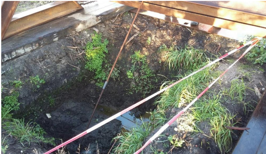
Figuur 6-5: Grondwaterstand ten tijde van het ontgraven van de toplaag
