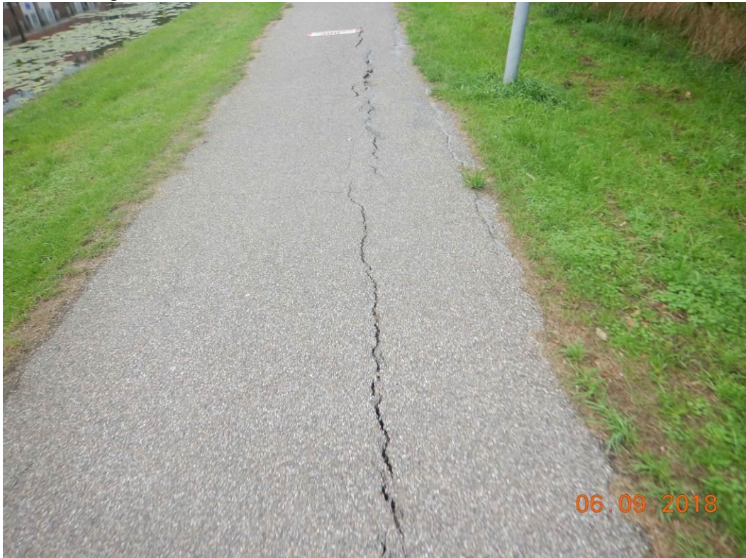
Scheurvorming asfaltconstructie:
