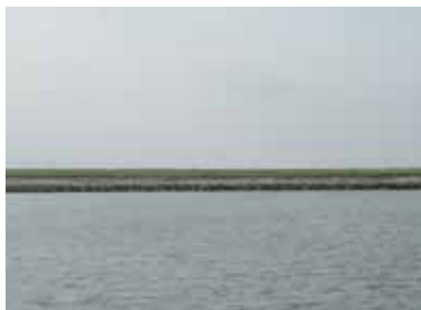
Oostvaardersdijk (ADC Heritage)
