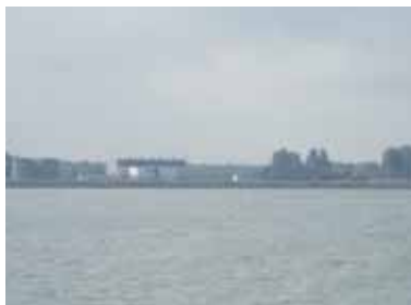
Gemaal Blocq van Kuffeler (ADC Heritage)
