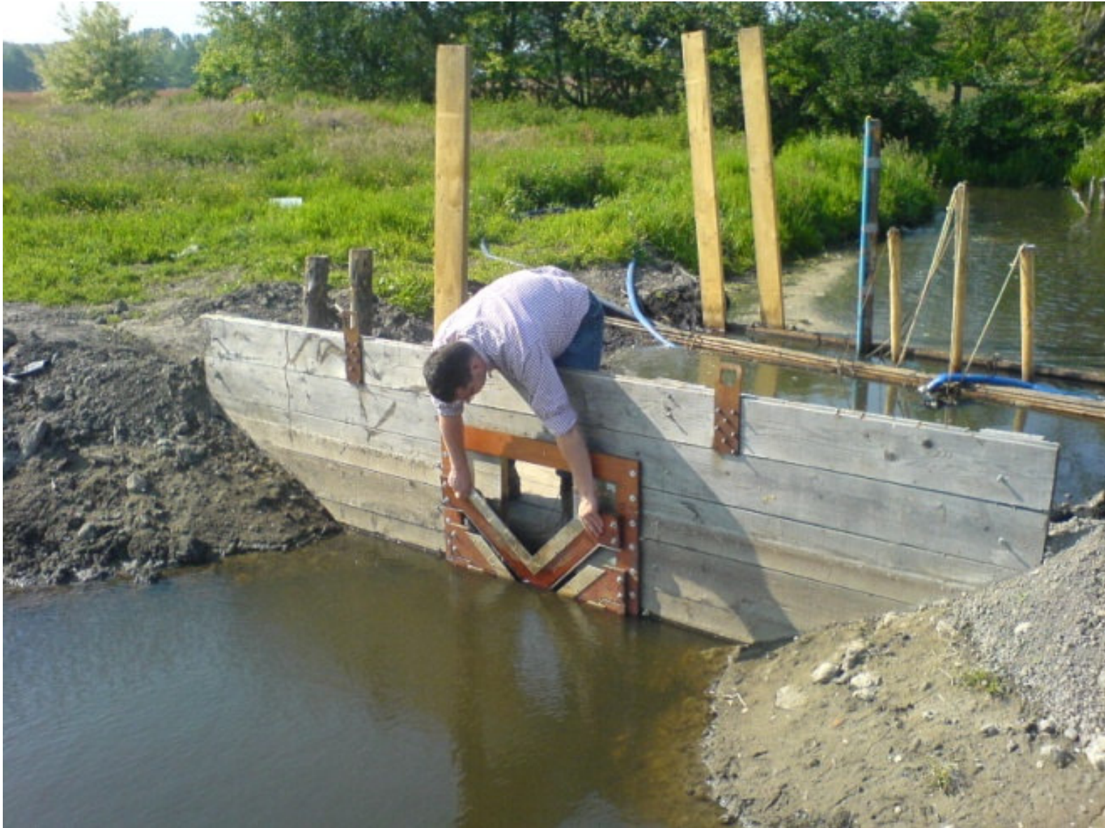
verwijderen van een V-notch segment uit het meetschot tijdens de slootproef
