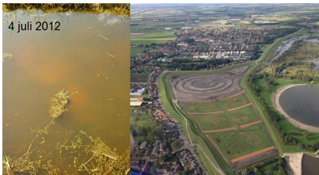
Figuur 3.25 Links een beeld van de watervegetatie in de omliggende sloot (zuidzijde polder) in 2012, en rechts een luchtfoto uit 13 februari 2013. De roestbruine kleur duidt op kwel.
