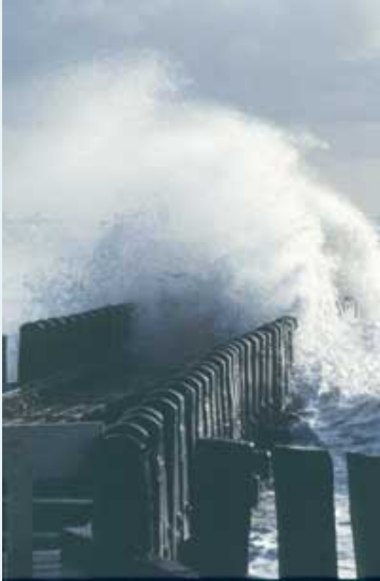
foto 4.4.2 Brekende golven op een palenrij langs de kust
