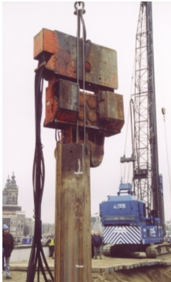
Trillend trekken van damwanden.
