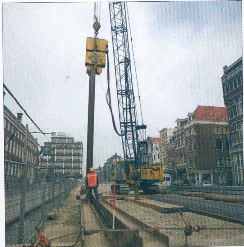
■ Figuur 1: Intrillen van een damwand in een stedelijke omgeving
