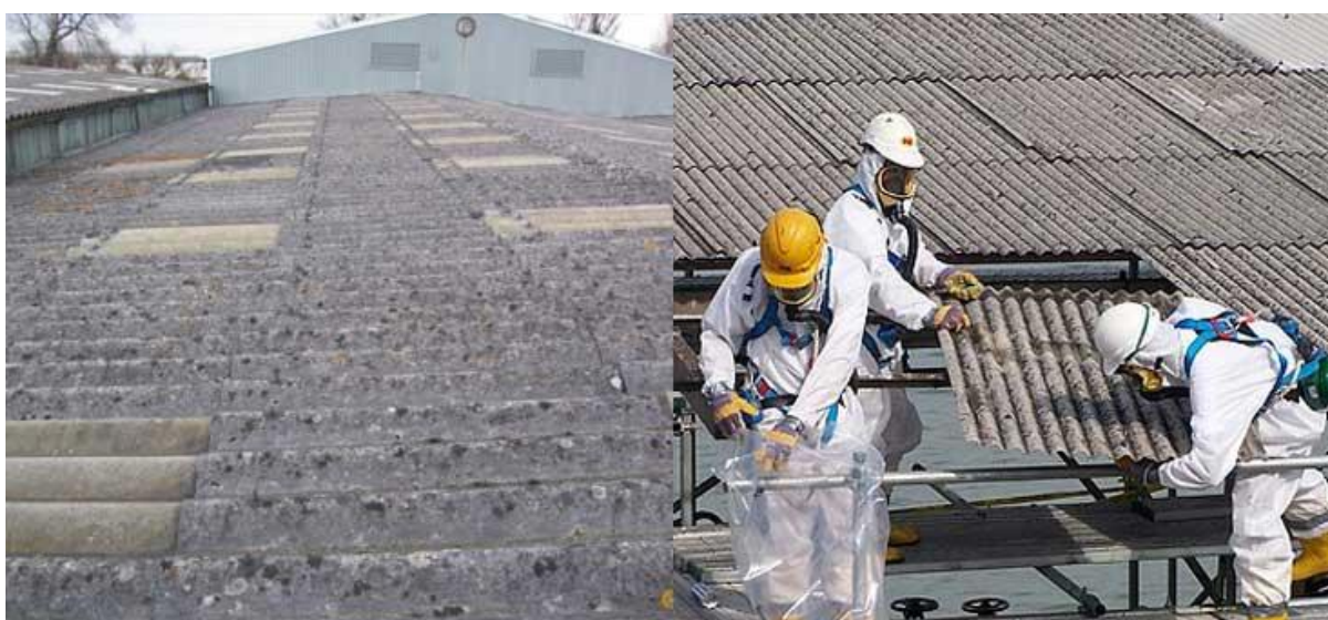
Figuur 1.1 Verwijdering van asbestdaken.
