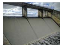
Paso Severino dam (Uruguay)
