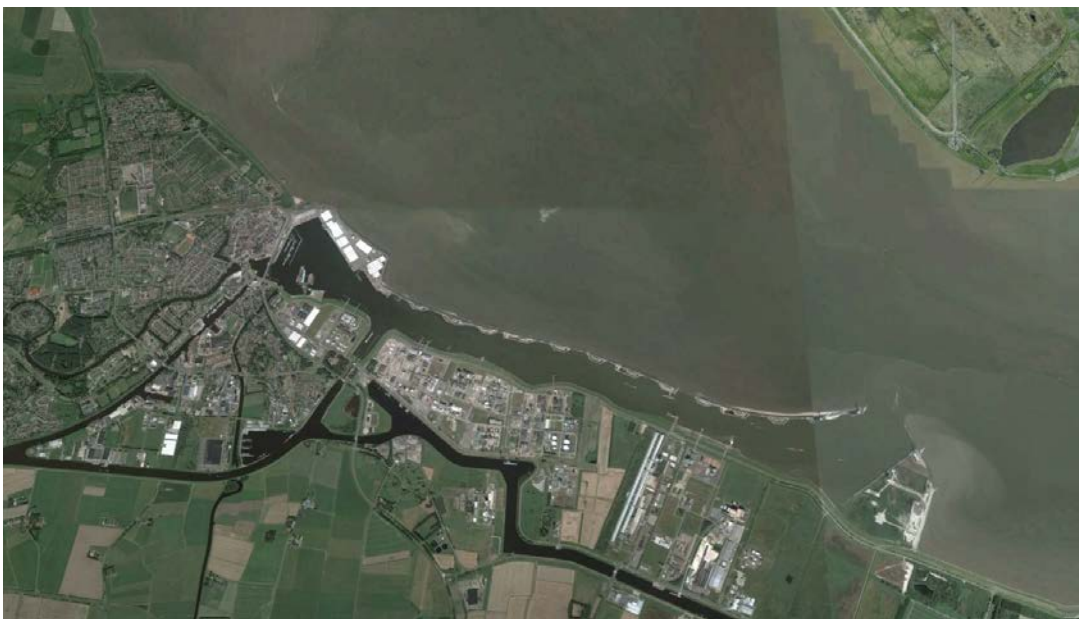
Figuur 4.1 Locatie van de strekdam langs de haven van Delfzijl
