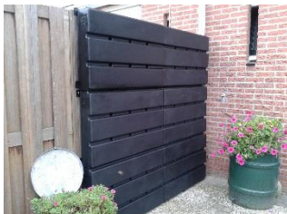
Figuur 37: Waterbergende schutting (Regenwaterschutting).
