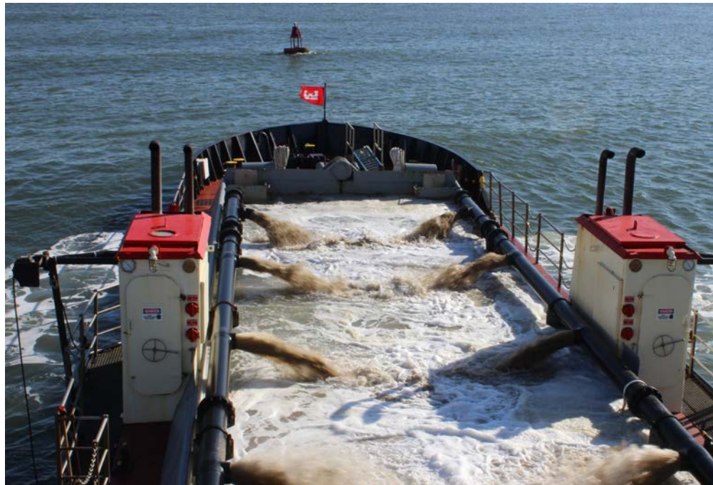
Het opspreiden van sediment bij een landwinningproject.
