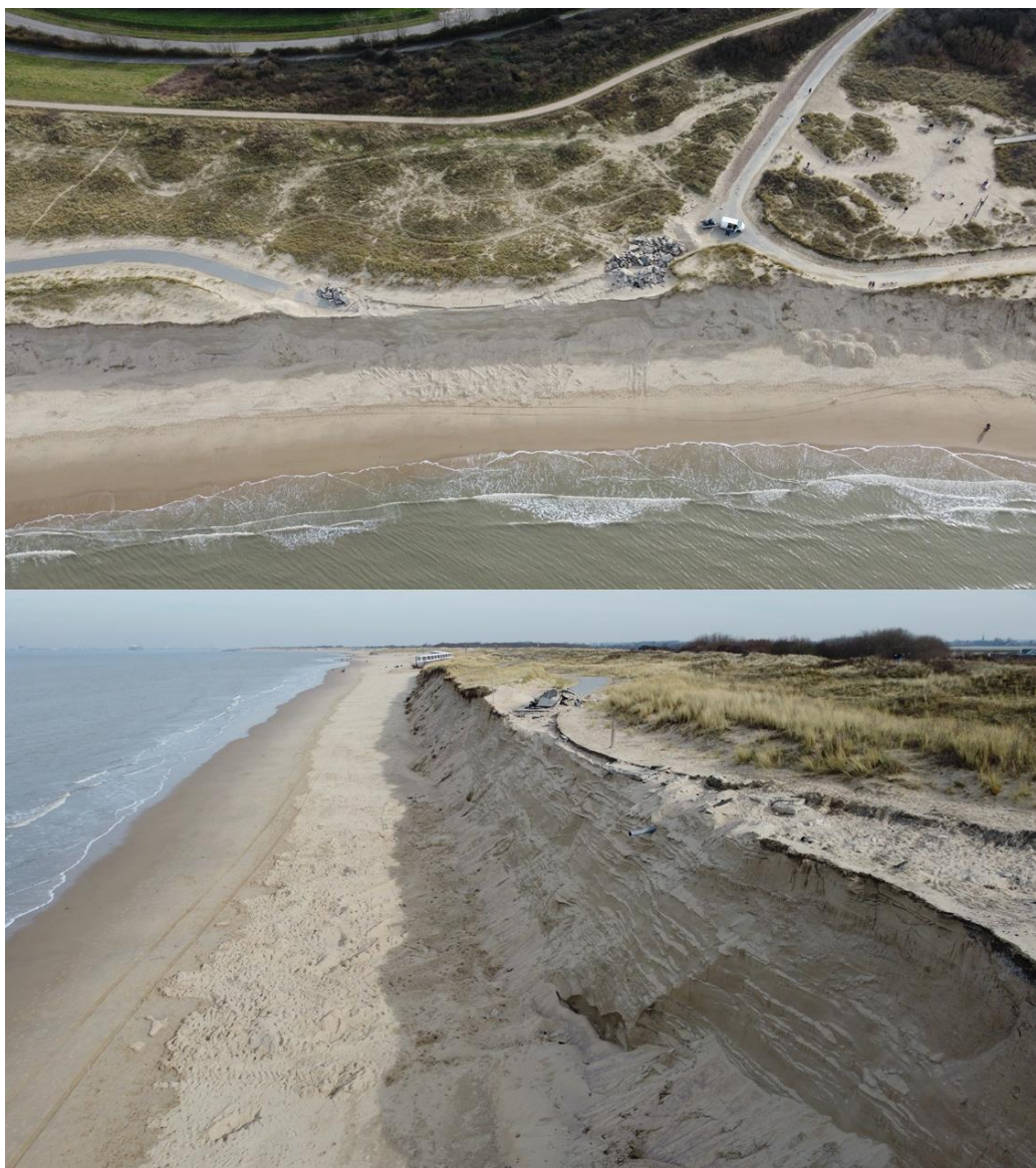
Figuur 5-4. Fietspad ingestort door duinafslag bij raai 778. Foto: Scheldestromen, voorjaar 2022.
