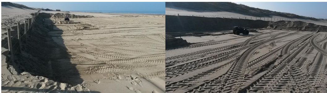
Figuur 1.3: Afgegraven duinvoet t.b.v. het plaatsen van strandpaviljoen (seizoensgebonden) in het voorjaar.
