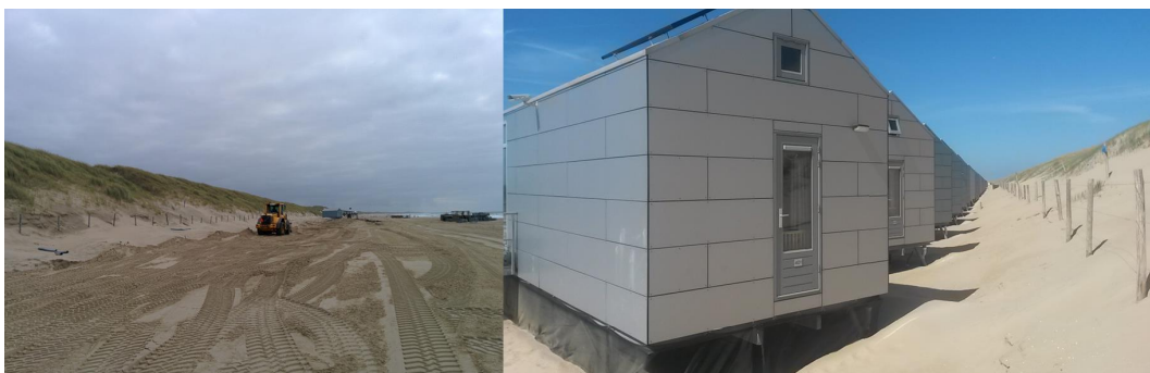
Figuur 1.4: Afgegraven duinvoet t.b.v. het plaatsen van tientallen vakantiehuisjes (seizoensgebonden). Links de opbouw, rechts het lint van huisjes.
