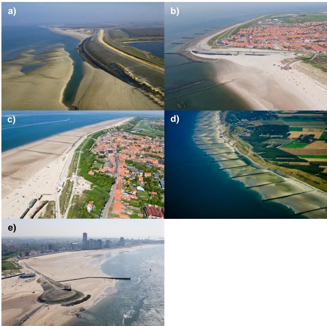
Figuur 5.2 Kustverdediging op Walcheren en Noord-Beveland: a) Veerse Gatdam met Oosterscheldekering op de achtergrond, b) Westkappelle Zeedijk, c) Dijk bij Zoutelande, d) Nolledijk, e) Dijk en kustbescherming boulevard Vlissingen. Op foto's b), c) en d) zijn ook de strandhoofden en palenschermen zichtbaar. Alle foto's afkomstig van http://beeldbank.rws.nl/ .
