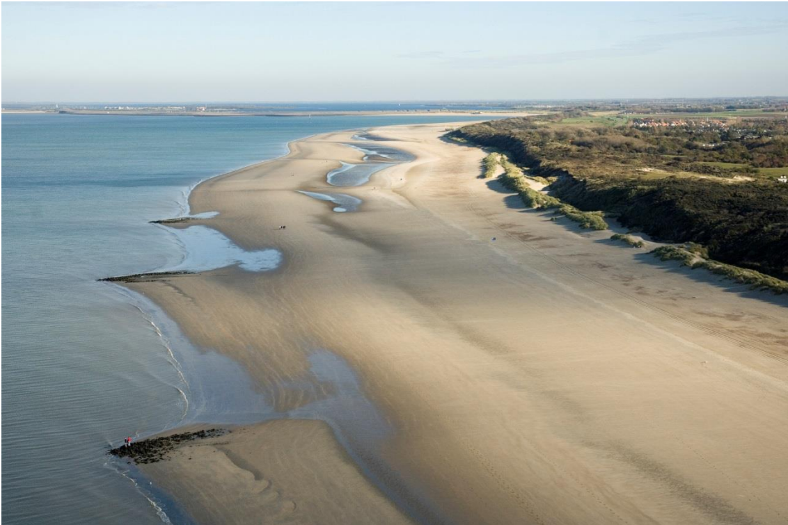
Figuur 3.3 Verklikkerstrand met zicht op de Brouwersdam en Renesse (foto Beeldbank Rijkswaterstaat Rens Jacobs, 2005)
