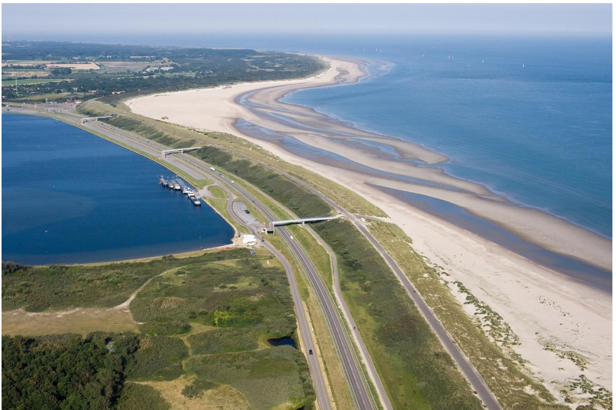
Figuur 3.10 Veerse Dam gezien in zuidelijke richting (2007, Beeldbank Rijkswaterstaat)
