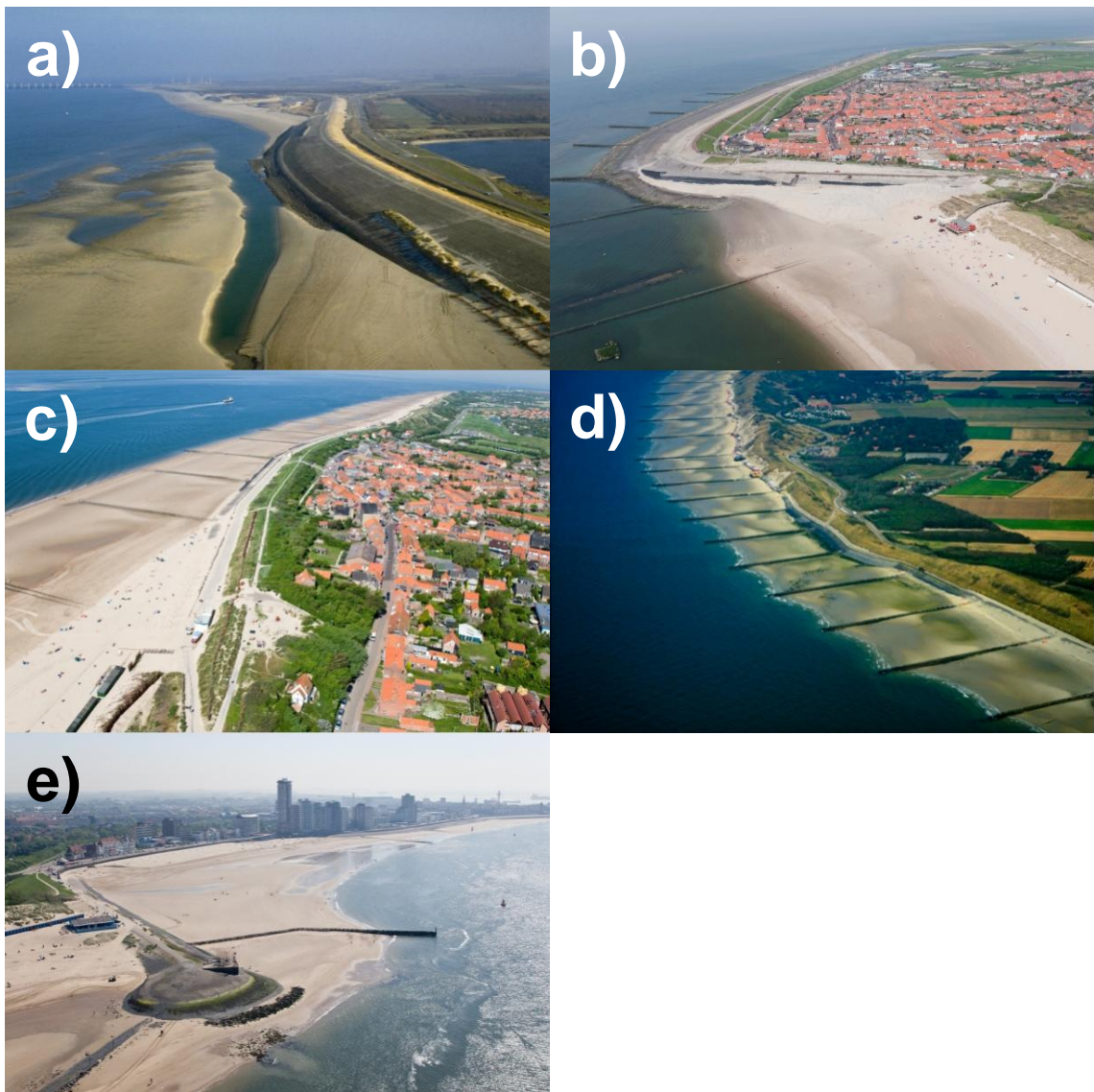
Figuur 5.6 Kustverdediging op Walcheren en Noord-Beveland: a) Veerse Dam met Oosterscheldekering op de achtergrond, b) Westkappelse Zeedijk, c) Dijk bij Zoutelande, d) Nolledijk, e) Dijk en kustbescherming boulevard Vlissingen. Op foto's b), c) en d) zijn ook de strandhoofden en palenschermen zichtbaar. Alle foto's afkomstig van http://beeldbank.rws.nl/ .
