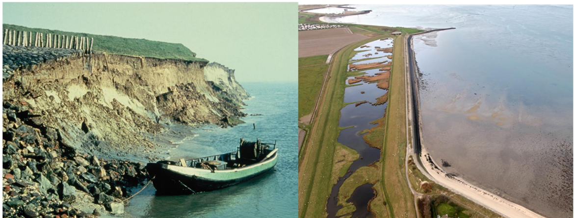
Figuur 5.3 Voorbeeld van een dijkval bij de Leendert Abraham polder (oostelijk Noord-Beveland) in 1966 (links) en een inlaag aan de noordzijde van het eiland (2008). Foto's: https://beeldbank.rws.nl , Rijkswaterstaat / Joop van Houdt.
