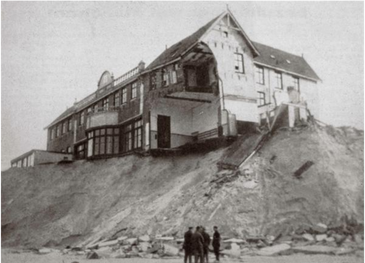
Figuur 5.3 instortend Badhotel 1923/24 door ondermijning als gevolg van duinerosie door stormafslag; https://beeldbank.rws.nl , Rijkswaterstaat
