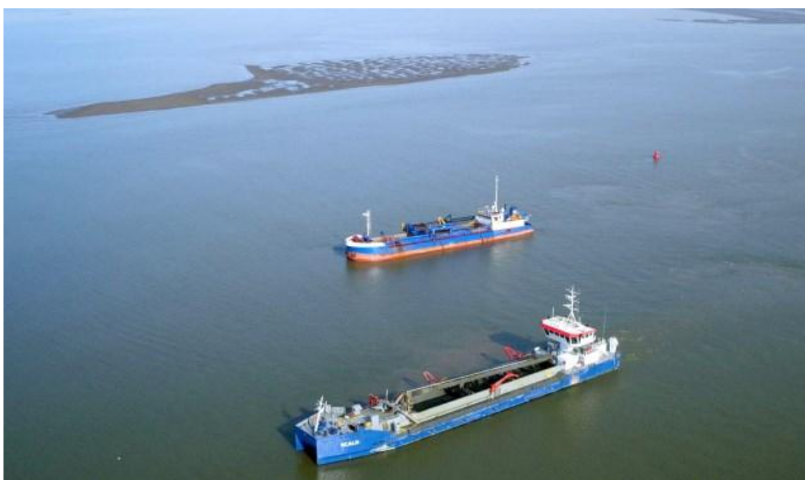
Foto 3.2 Twee zuigers aan het werk in Slijkgat (Zandzuigbedrijf Faasse BV, Goes)
