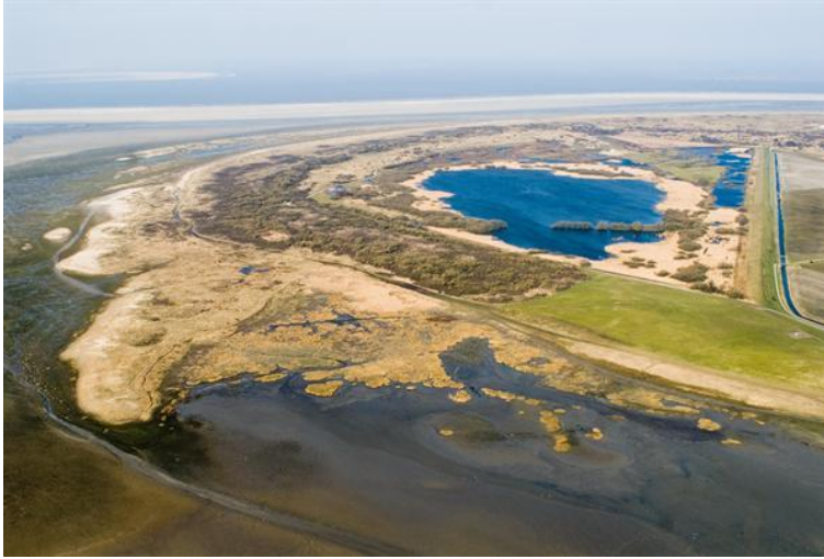
Figuur 4-3. Westerpolder kijkend naar het noorden: Rechts is de oorspronkelijke dijk van de Banck nog zichtbaar, zuidelijk ervan bedekt de Waterstaatsdijk deze dijk en gaat naar het westen (links) over in een stuifdijk. Foto 2007; https://beeldbank.rws.nl , Rijkswaterstaat / Joop van Houdt.
