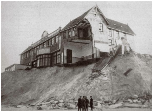
Figuur 4-4. Instortend Badhotel 1923/24 door ondermijning als gevolg van duinerosie door stormafslag; https://beeldbank.rws.nl , Rijkswaterstaat.
