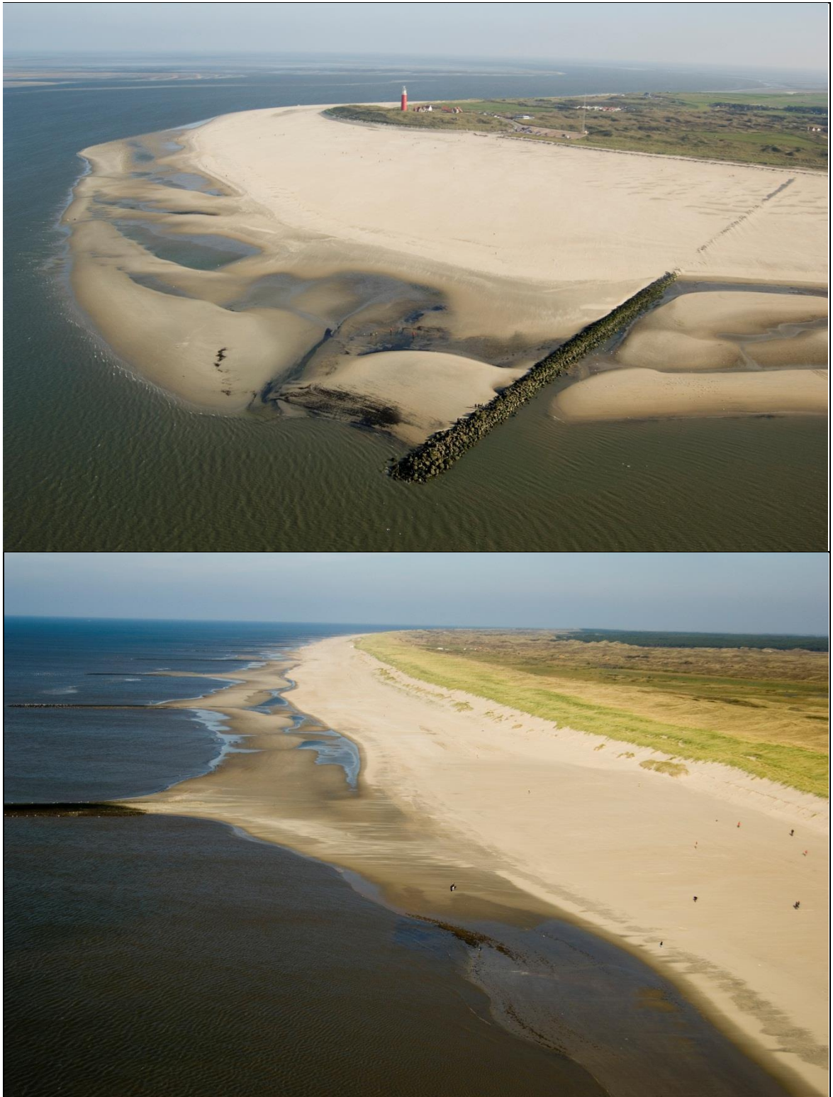
Figuur 4.1 : Kustverdediging Texel ( https://beeldbank.rws.nl , Rijkswaterstaat). Boven: de Eilerlandse Dam beschermt Bolwerk Eierland. Onder: strandhoofden aan de zuidwestzijde van het eiland (ten westen van Den Hoorn).
