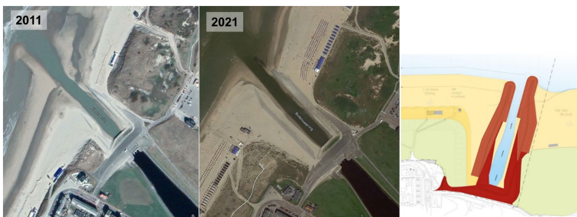
Figuur 2-4 Uitwateringssluis bij Katwijk in 2011 (links), 2021 na verlenging met 50m (midden) en het ontwerp van de verlenging (rechts). Bron: Google Earth en Arcadis (2013)
