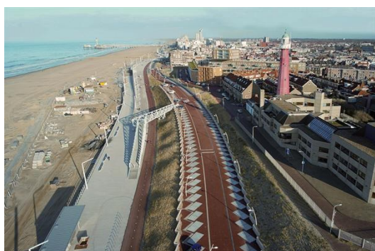
Figuur 2-3 - Kustversterking Zwakke Schakel Scheveningen. Dijk-in-boulevard. Bron: https://beeldbank.rws.nl , Rijkswaterstaat / Harry van Reeken.
