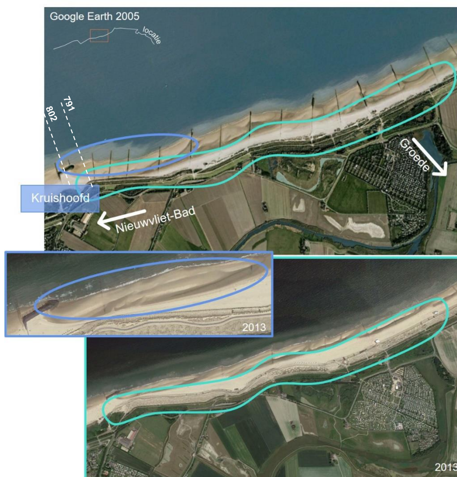
Figuur 5-11; Overzicht van de Zwakke Schakel versterking bij Nieuwvliet-Groede in 2009. De paarse kleur geeft de locatie van de erosieberm weer, en de groene de duinversterking (Vermeer en van der Werf, 2022).
