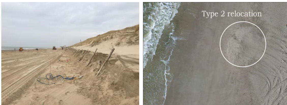
Figuur 3-5 Links: Aanleg van een zandbanket voor lintbebouwing, door afgraven van de duinvoet. (De Klerk, 2019)
