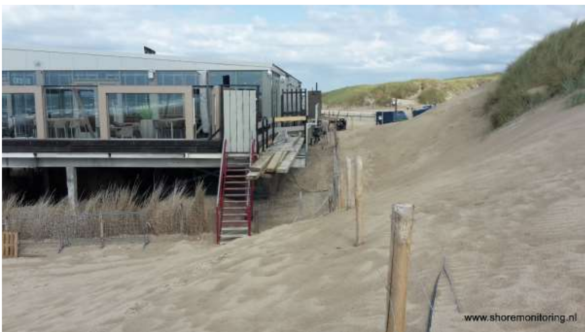
Foto 9: Close up situatie achter Paal 6.
