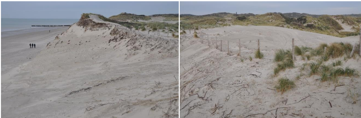
Figuur 6-13 Schouwen, Meeuwenduinen. De meest zuidelijke van de twee in 2017 aangelegde kerven met links de helling vanaf het strand en rechts de vlak geblazen bovenkant van de vrije-val helling aan de landzijde (zie voor de ligging figuur 6.3). Foto 23 nov 2019, L. van der Valk.
