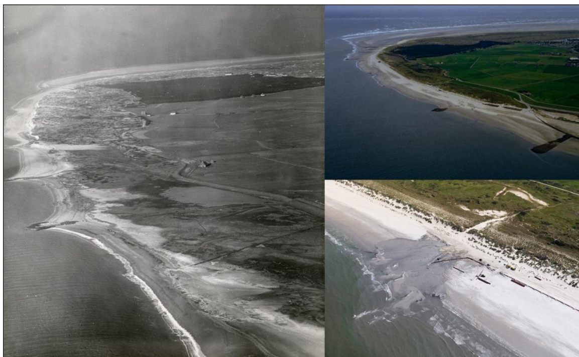
Figuur 5.1 : Kustverdediging Ameland ( https://beeldbank.rws.nl , Rijkswaterstaat). Links: Strandhoofden beschermen de eilandkop ter plaatse van het Borndiep in 1954. Rechtsboven: kustverdediging Borndiep in 2007 en uitvoering van een suppletie op de eilandkust.
