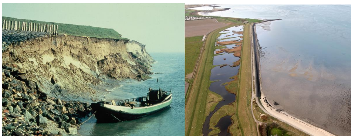
Figuur 5.3 Voorbeeld van een dijkval bij de Leendert Abrahamspolder (oostelijk NB) in 1966 (links) en een inlaag aan de noordzijde van het eiland (2008). Foto's: https://beeldbank.rws.nl , Rijkswaterstaat / Joop van Houdt.
