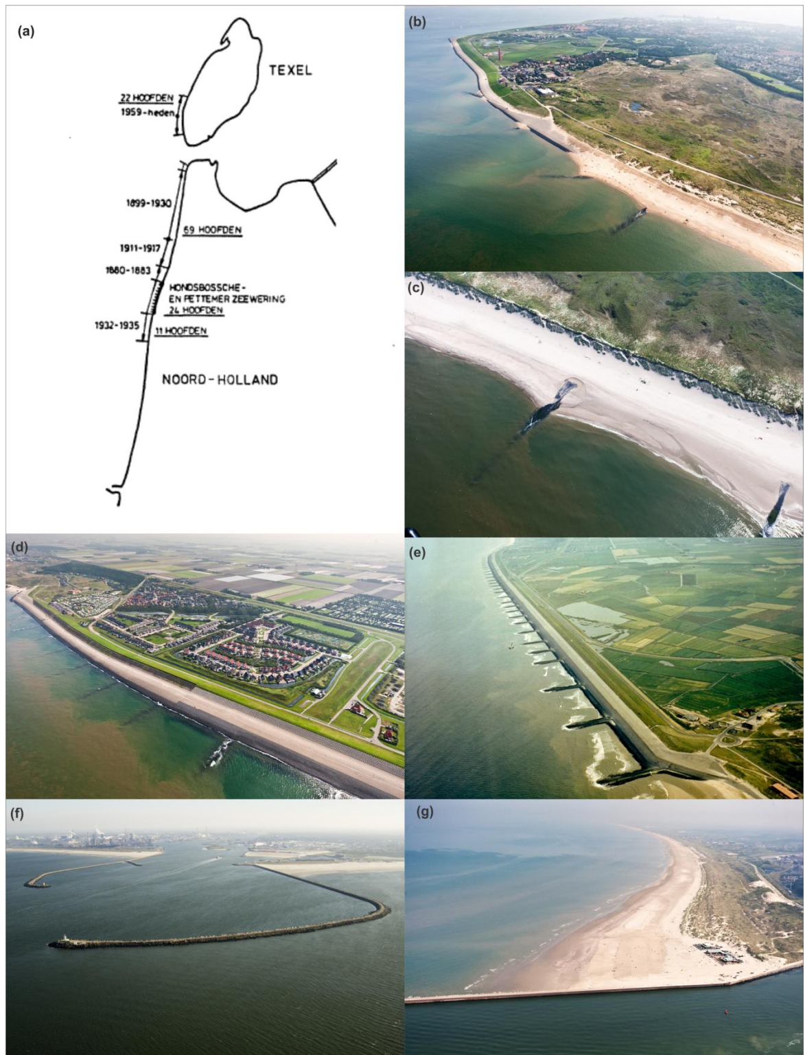
Figuur 5.1 Overzicht van 'harde' constructies in het Noord-Hollandse kustvak: (a) aanleg strandhoofden uit Verhagen en van Rossum (1990), (b) Helderse Zeewering, (c) hoofden tussen Helderse en Hondsbossche zeewering, (d) Hondsbossche en Pettemer Zeewering in 1982, (e) overgang van Pettemer naar Hondsbossche Zeewering in 2011, en (f,g) havendammen van IJmuiden en de aanzanding in 2011 aan de noordzijde daarvan. Alle foto's zijn afkomstig van: https://beeldbank.rws.nl , Rijkswaterstaat.
