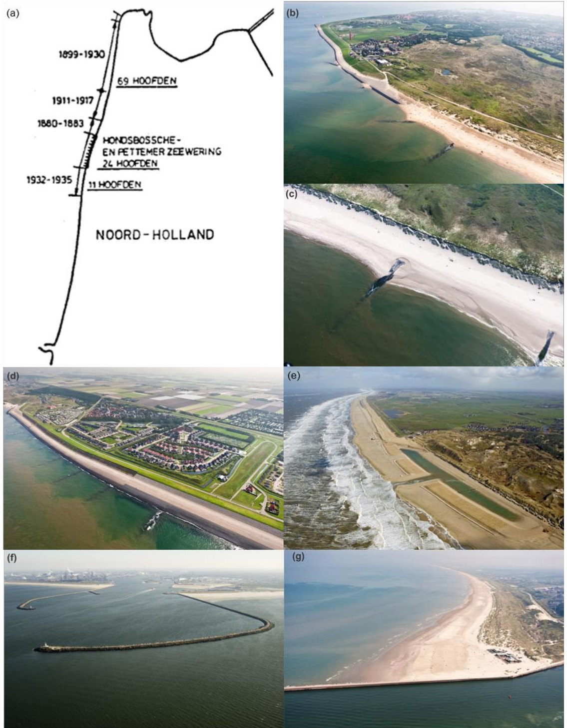
Figuur 4-1 : Overzicht van 'harde' constructies in het Noord-Hollandse kustvak: (a) aanleg strandhoofden uit Verhagen en van Rossum (1990), (b) Helderse Zeewering, (c) hoofden tussen Helderse en Hondsbosse zeewering, (d) Hondsbosse en Pettemer Zeewering in 1982, (e) Hondsbosse Duinen (foto: EcoShape), en (f,g) havendammen van IJmuiden en de aanzanding in 2011 aan de noordzijde daarvan. Alle foto's zijn afkomstig van het Beeldarchief Rijkswaterstaat (m.u.v. (e)).
