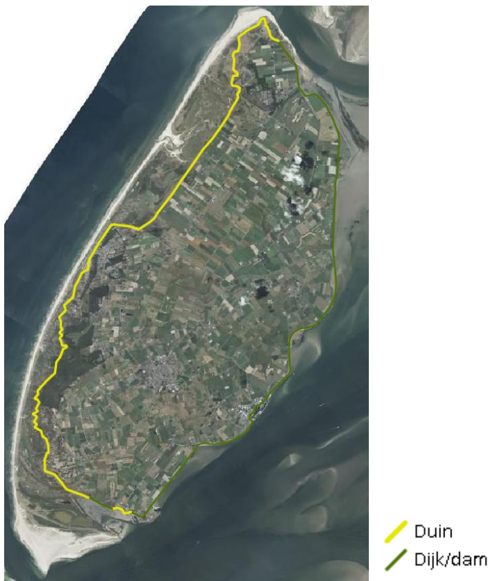
Figuur 4.5 - Overzicht van dijktraject 5 primaire waterkering, onderscheid gemaakt in duin (geel) dijk/dam en (donker groen). Bron: https://hknk.webgispublisher.nl/Viewer.aspx?map=Digitale-ontsluiting-legger-primaire-waterkeringen#
