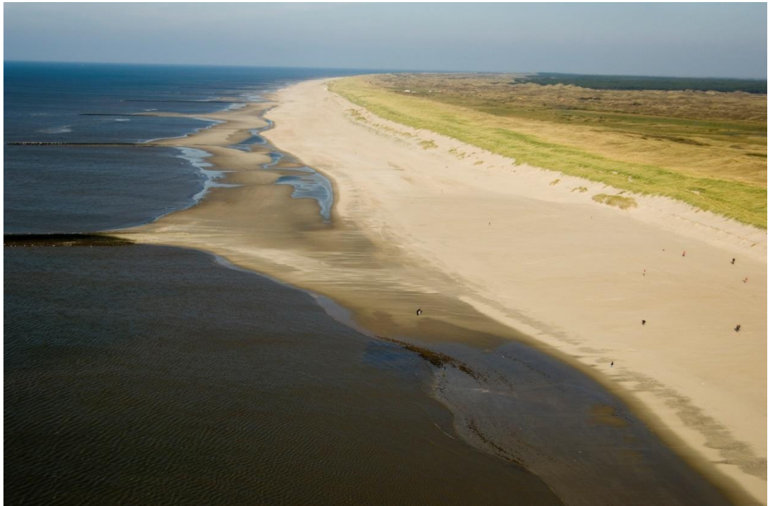
Figuur 4.2 - Kustverdediging Texel ( https://beeldbank.rws.nl , Rijkswaterstaat), strandhoofden aan de zuidwestzijde van het eiland (ten westen van Den Hoorn).
