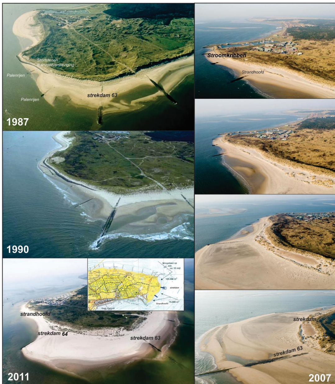
Figuur 4-5 - Kustverdediging aan de Noordoostkop van Vlieland voor de jaren 1987, 1990, 2011 (links) en 2007 (rechts). Bijgevoegd in 2011 is een overzicht van de in 1995 aangelegde kustverdediging bestaande uit een combinatie van een strekdam, strandhoofd en een zandsuppletie (uit Teerenstra, 1999).
