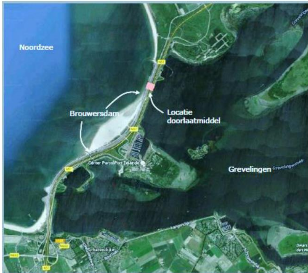
Foto 3.2 Locatie getijdencentrale in de Brouwersdam 3
