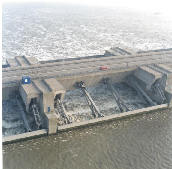
Foto 3.1 Haringvlietsluizen (detail, deels gesloten deur), Beeldbank Rijkswaterstaat
