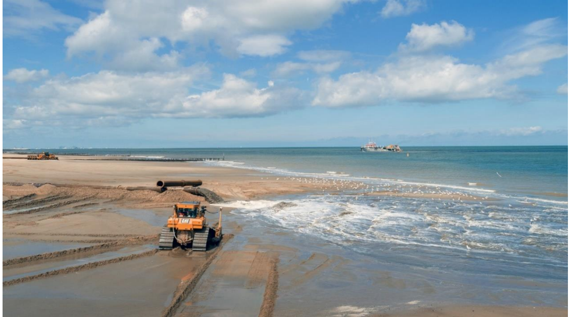
Figuur 2.3 - Uitvoering strandsuppletie tussen Nieuwvliet en Nieuwesluis, Zeeuws-Vlaanderen, september 2019 (Foto: Rijkswaterstaat).
