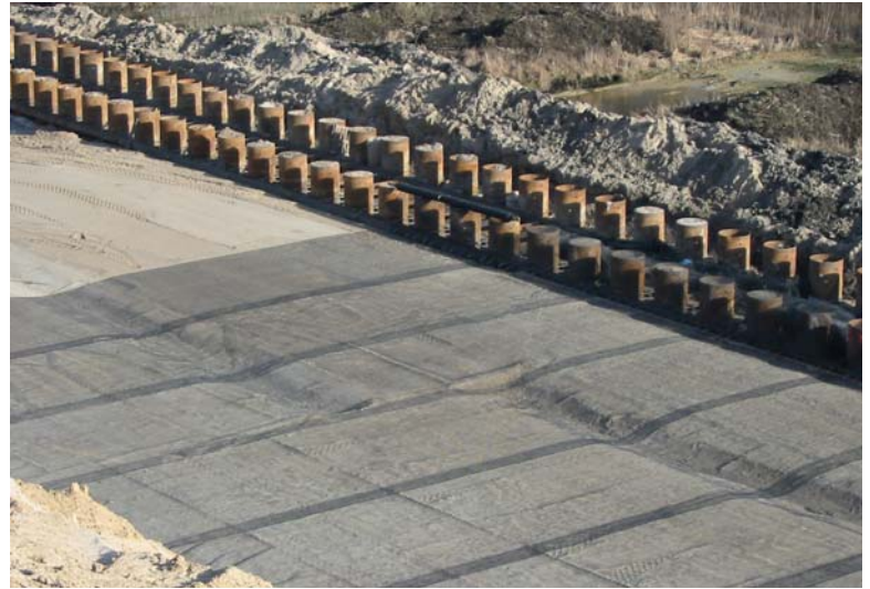
Foto 9 – Horizontale verankering van stalen buispalen.
