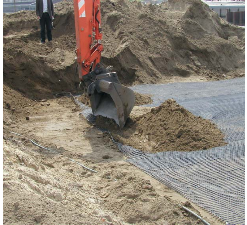
Foto 7 – Borgen met grond en voorspannen van het geogrid door het geogrid over een geul te leggen.
