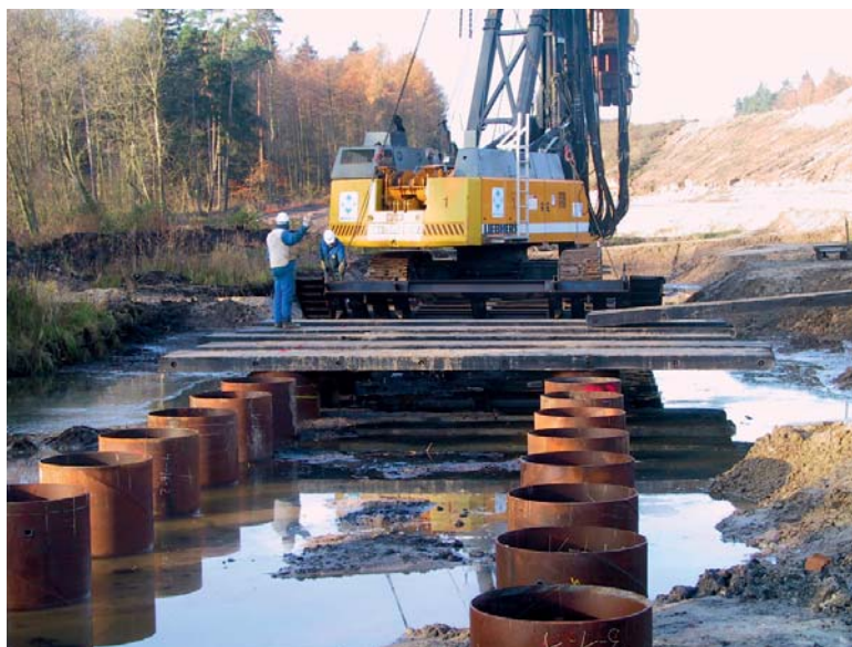
Figuur 10 – Werkplatform op stalen buispalen.
