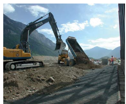
Figuur 3 – De bouw van de tijdelijke brug in Zwitserland.
