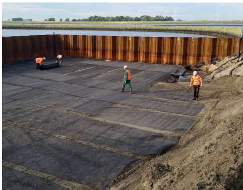
Figuur 13 – Bouwkuip kraanopstelplaats Krammer.
