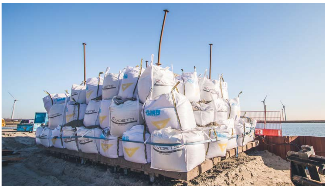
Figuur 5 – Proefbelasting, belastingoppervlak is 3 x 6 m 2 , oppervlakte bigbags = 5 x 8 m 2 .
