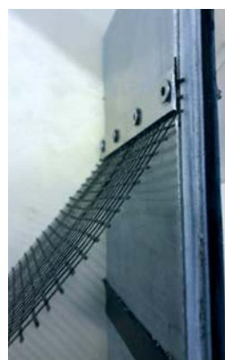
d. Verbinding geogrid-damwand in de proeven.
