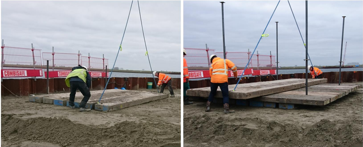
Abbildung 4.14 Herstellen der Aufstellflächen der Totlast
