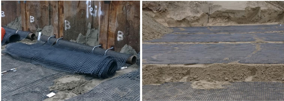
Abbildung 4.4 Anschluss der Geogitter an die Spundwand und Einbau von Sand zwischen den Lagen
