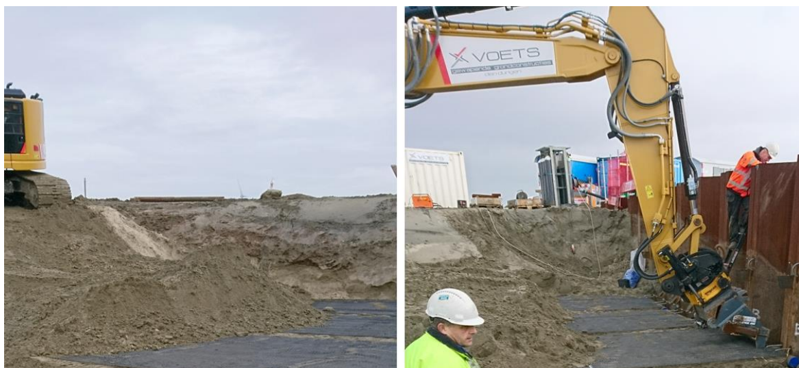
Abbildung 4.7 Vorspannen der Geogitter
