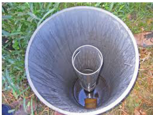
REGELPUT REGELBARE DRAINAGE (BRON: STUYT, 2012)
