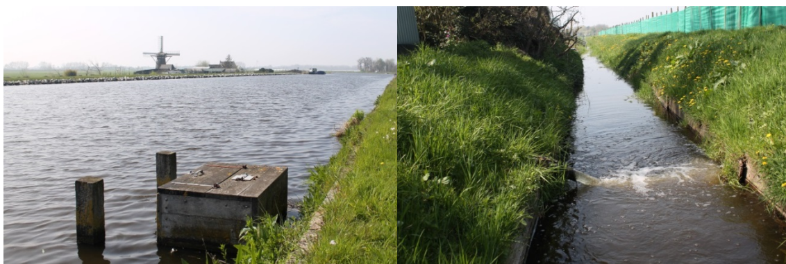
Figuur 2.2 Handmatig bediende inlaat langs de Haarlemmermeer. De afsluiter bevindt zich in de kast op de linkerfoto.
