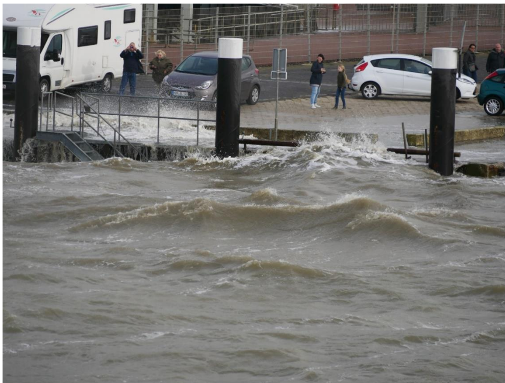
Figuur 2-6: Hoogwater bij de veerdam te Holwerd.
