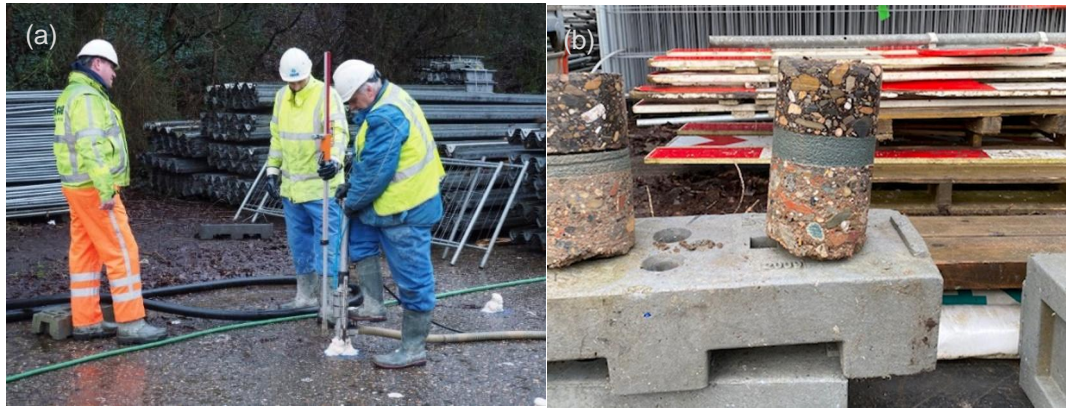
Figuur 4.20 Werkzaamheden Faber (a) injectie van celbeton; (b) boorkernen met celbeton
