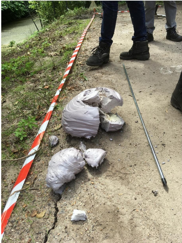
Figuur 4.11 Scheuren van berm aan slootzijde met uitbraak materiaal bij ondiep injecteren op punt 229
