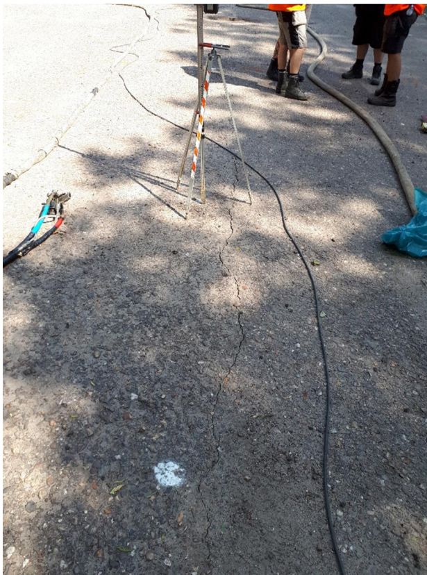
Figuur 4.12 Langsscheur nabij raai 300 bij injecteren op punt 227
