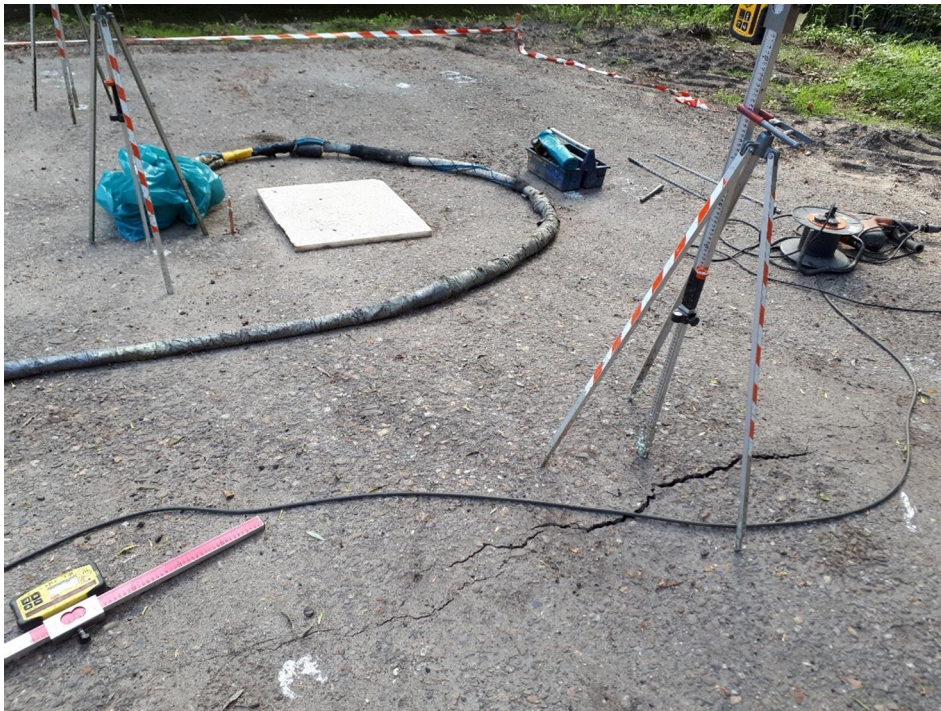
Figuur 4.10 Opbolling en langsscheur nabij raai 300 bij ondiep injecteren op punt 229
