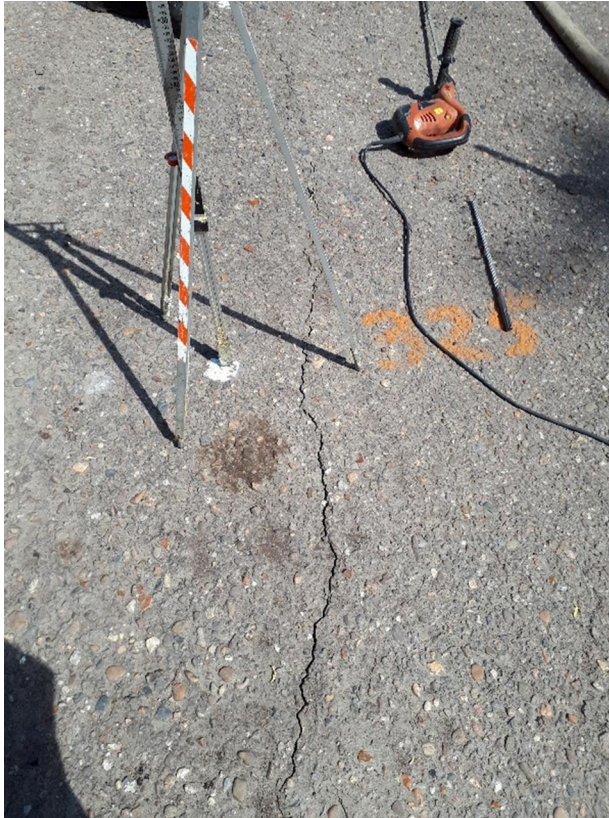
Figuur 4.13 Doorgegroeide langsscheur nabij raai 300 bij injecteren op punt 225
