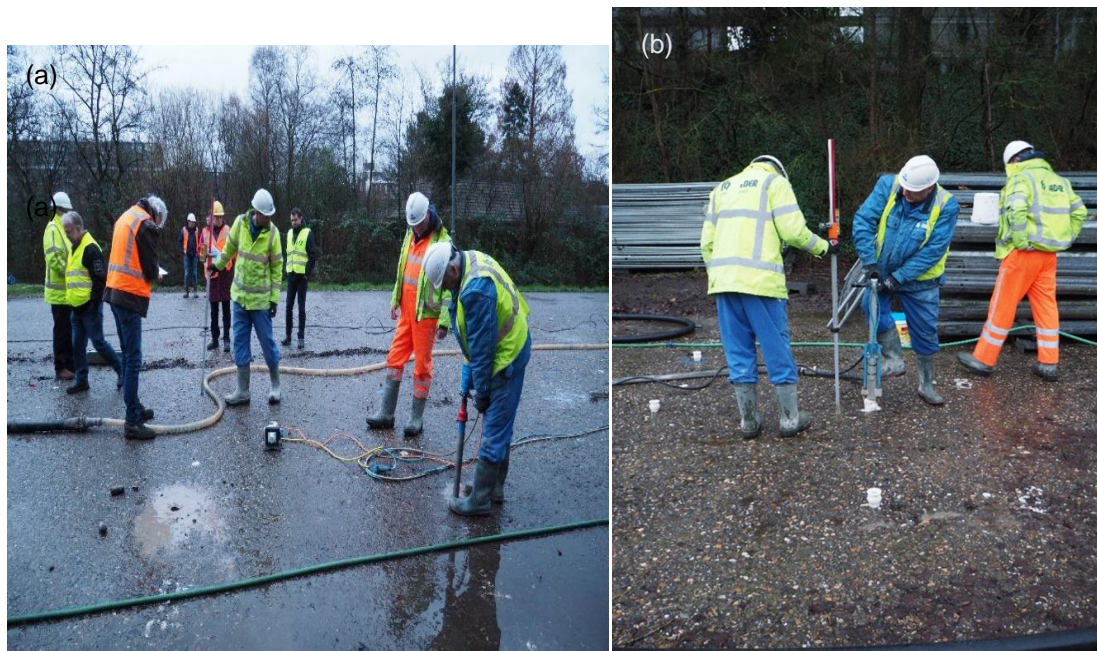
Figuur 4.19 Werkzaamheden Faber (a) boren van de gaten; (b) schuimen door de injectiepluggen
