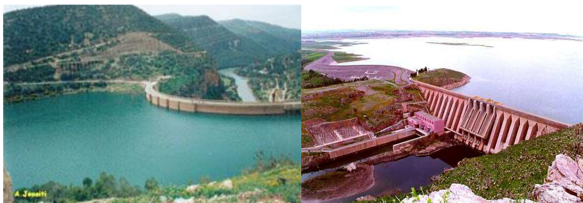
Bin A Ouidane dam
