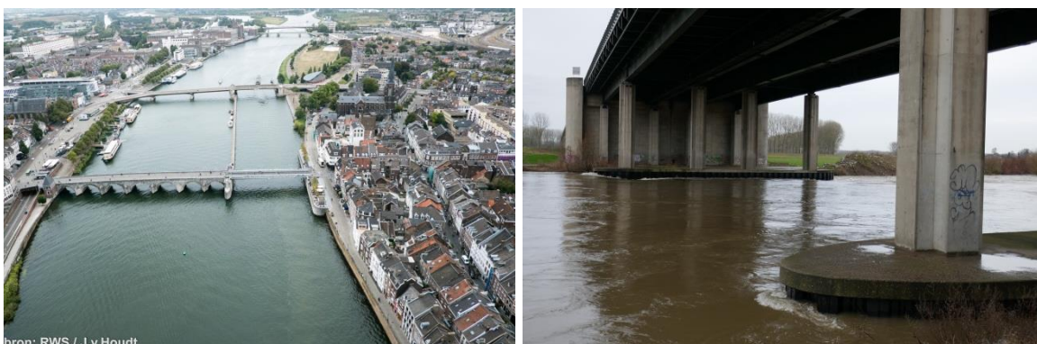
Foto 2.9 Links: Sint Servaasbrug met op de achtergrond de Wilhemina- en de Spoorbrug (Maastricht) (Foto's: J.v.Houdt, beeldbank RWS); Rechts: Brug bij Elsloo in januari 2018
