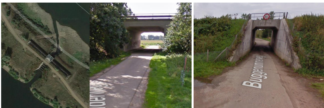
Foto 2.8 Links: Inlaatconstructie retentiegebied Negenoord; Midden: Verbinding tussen LKW-Noord / Zuid; Rechts: Fietserstunnel bij Buggenum (Buggenummerweg) (bron: Google Streetview)
