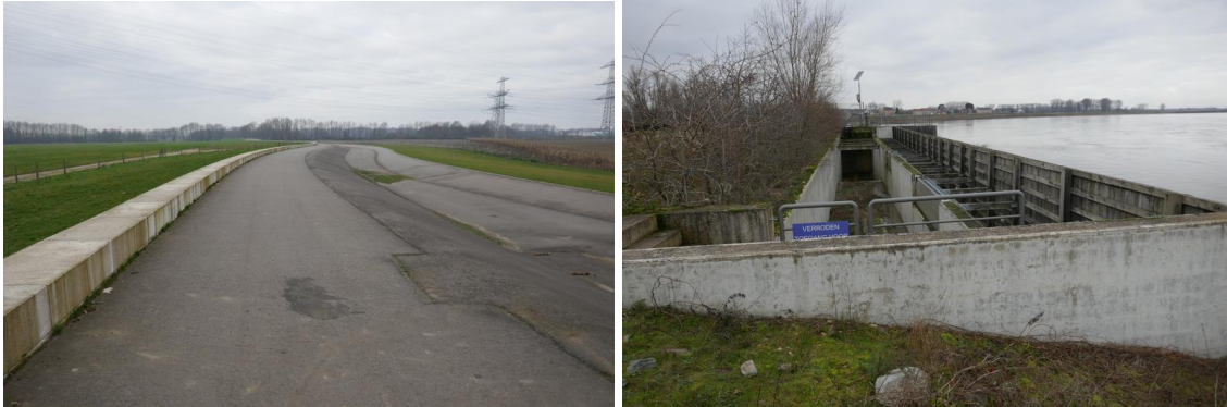
Foto 2.10 Links: Inlaatconstructie LKW; Rechts: Inlaatconstructie retentiegebied Negenoord
