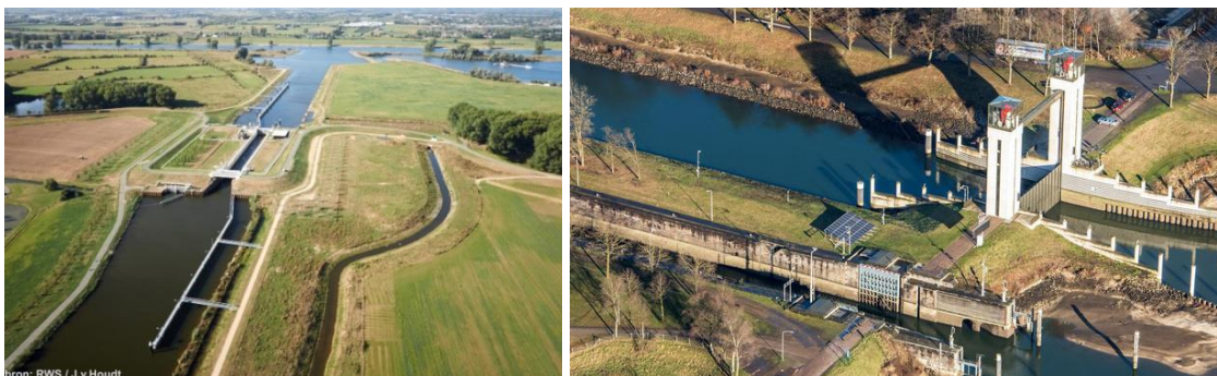
Foto 2.6 Voorbeelden van enkele sluisen langs de Maas. Links: Schutsluis Empel naar het Maximakanaal (foto: J.v.Houdt, beeldbank RWS); Rechts: Schutsluis en keersluis Heumen (foto: Raymond Rutting, Volkskrant)
