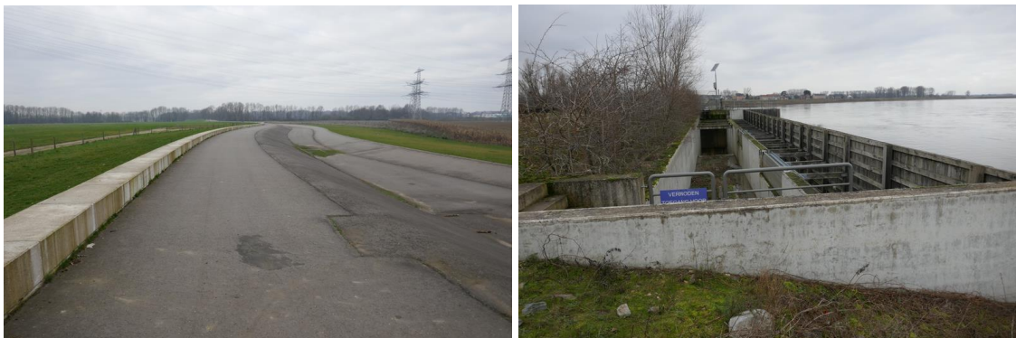
Foto 2.10 Links: Inlaatconstructie LKW; Rechts: Inlaatconstructie retentiegebied Negenoord
