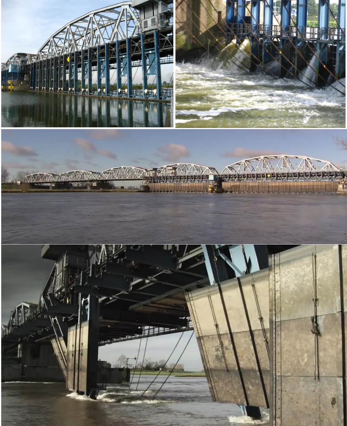
Figuur: (Linksboven) De 11 jukken met hierop de rijen schuiven onder het meest westelijke deel van de brug, met aan weerszijden de grijze kraanwagens. (Rechtsboven) Detailopname van het oostelijke stuwdeel waarbij 1 schuif van de bovenrij (links op de foto) getrokken is. (Midden) Beide brugdelen waaronder de stuw hangt zijn hier zichtbaar, alle schotten zijn gehezen dus de stuw wordt bijna gestreken. (Onder) De stuw wordt gestreken en 2 van de 4 jukken hangen reeds "op stroom". (Van Aubel, 2016)
