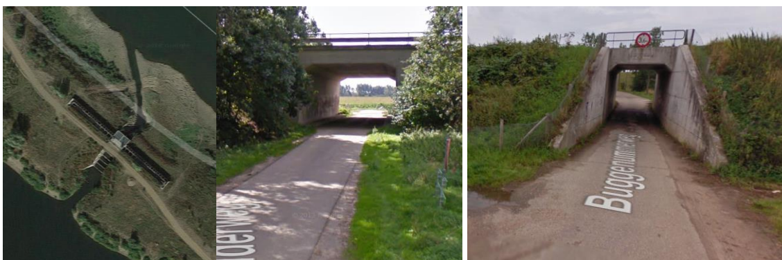
Foto 2.8 Links: Inlaatconstructie retentiegebied Negenoord; Midden: Verbinding tussen LKW-Noord / Zuid; Rechts: Fietserstunnel bij Buggenum (Buggenummerweg) (bron: Google Streetview)
