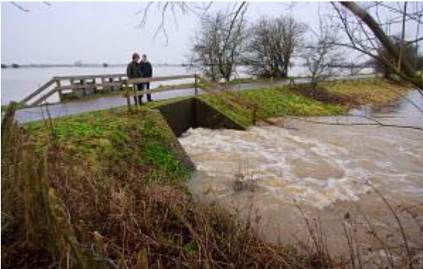
Figuur 2.11 Inlaatsluis in de zomerdijk bij Wageningen (bron: Nationale Beeldbank).
