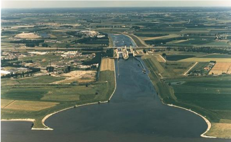
Figuur 2.10 Prins Bernhardsluizen bij Tiel (bron: beeldbank RWS)
