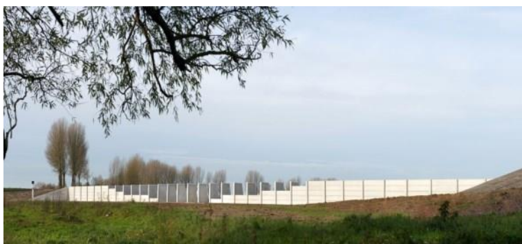
Figuur 2.7 Regelwerk Pannerden (bron: www.rijnwaardenseuiterwaarden.nl )
