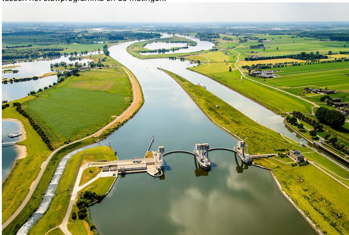
Figuur 2.6 Overzichtsfoto van het stuwcomplex Amerongen in benedenstroomse richting, met links direct naast de vizerschuiven de WKC Amerongen en meest links de vistrap (bron: wikimapia.org).
